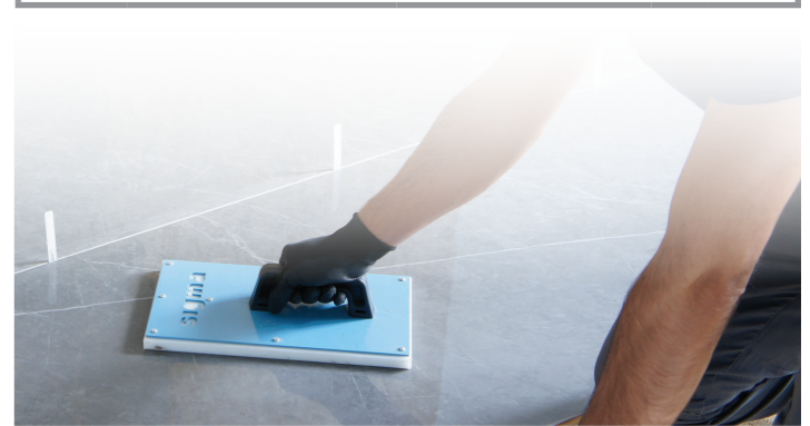
Fliesen-Fugbrett 16x33 cm zum korrekten Ausstoßen der Luft unter der Fliese.
