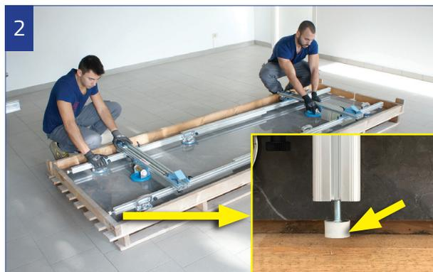
Adattare il telaio alla lastra e distribuire le ventose in maniera omogenea, mettere in depressione le ventose, posizionando i piedi in gomma fuori dalla lastra.
