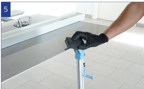
5 Al termine della lavorazione è possibile rifinire il bordo tagliato con un tampone diamantato per la finitura.
