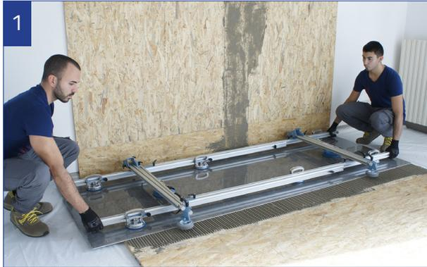
Posa a terra con telaio di movimentazione KERA-LIFT.
