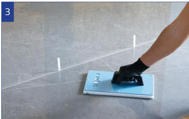
Distribuire i livellatori e battere manualmente la lastra tramite l'apposito frattazzo Battipiastrelle (Art. 42E) o tramite il Battipiastrelle Elettrico Vibrante (Art. 42F) per garantire la completa fuoriuscita dell'aria, partendo dal centro verso i lati nella stessa direzione della spalmatura.
