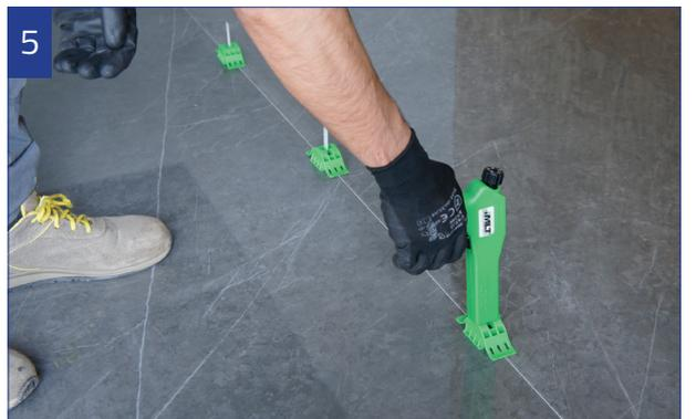
Mettere in tensione i livellatori e rimuoverli solo dopo la completa essiccazione dell'adesivo.
