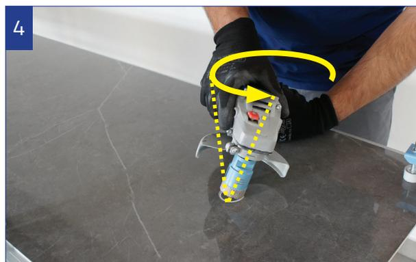
Proseguire la foratura con movimento oscillatorio senza spingere eccessivamente, raffreddando la fresa con acqua all'occorrenza.
