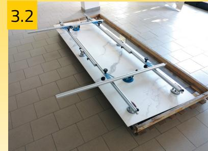
Appoggiare la lastra sul lato lungo della cassa e applicarvi il telaio.
